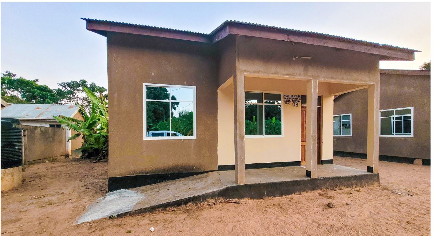
Moja kati ya nyumba sita za walimu zilizojengwa katika Shule ya Sekondari ya Vikumburu Halmashauri ya Wilaya ya Kisarawe mkoani Pwani kwa ufadhili wa Mfuko wa Elimu wa Taifa.
